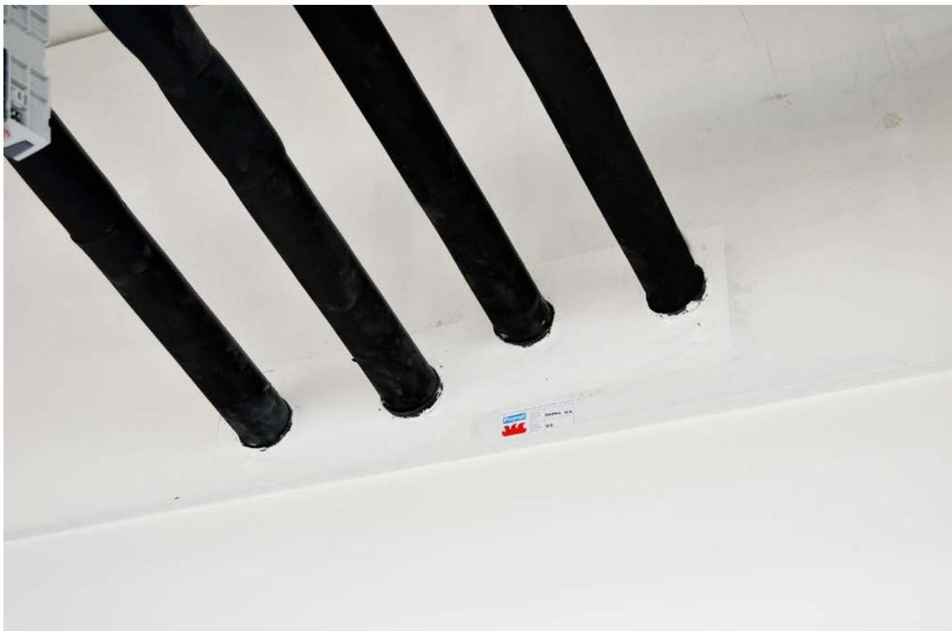
Prostupy potrubí s požárně ochranným pásem PROMASTOP®-W
