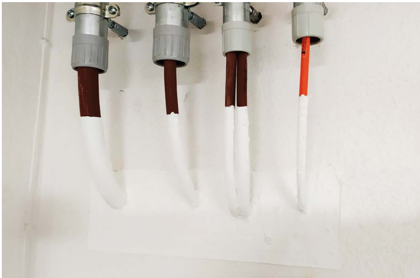
Kabelová měkká desková přepážka se stěrku PROMASTOP®-I
