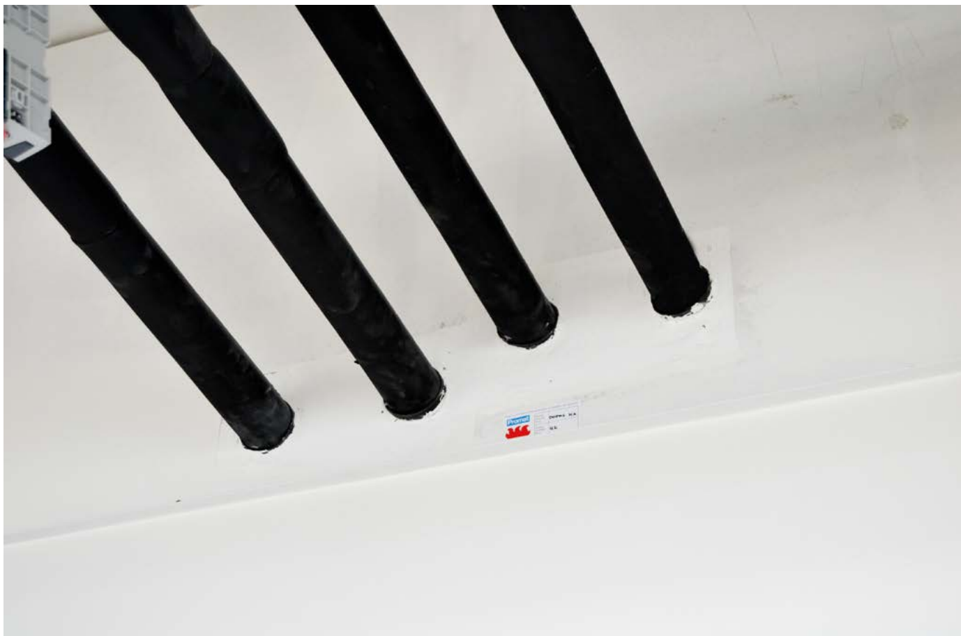
Prostupy potrubí s požárně ochranným pásem PROMASTOP®-W
