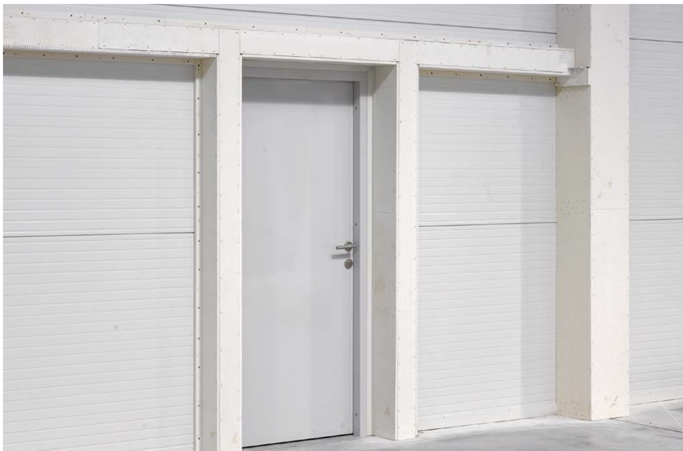
Obklad ocelové konstrukce deskami PROMATECT®-XS
