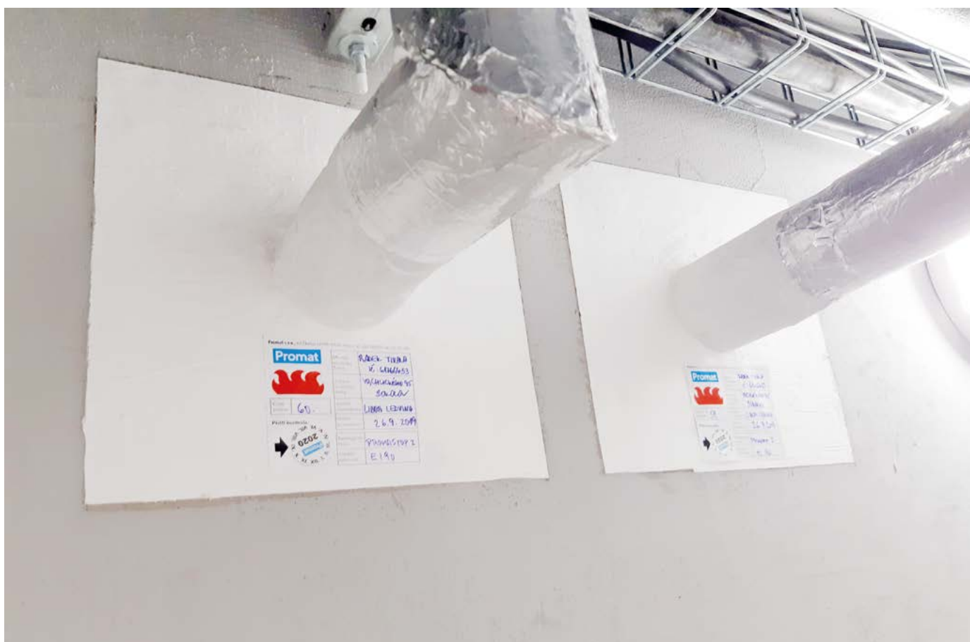
Prostup ocelového potrubí s nehořlavou izolací a stěrkou PROMASTOP®-I
