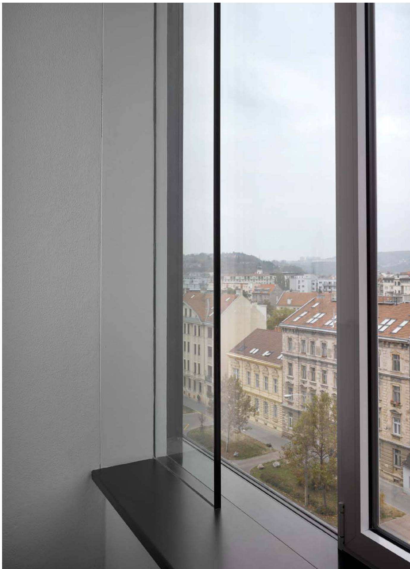
Svislý požární pás ze skel Promat®-SYSTEMGLAS
