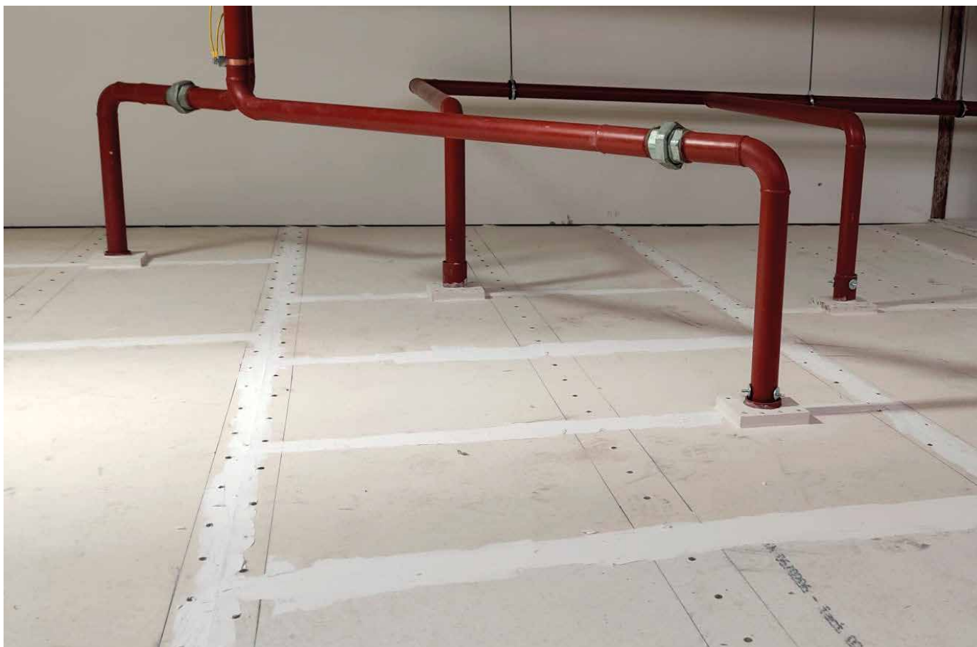
Pohled shora na samonosný podhled PROMATECT®-H, ve funkci samostatného požárního předělu dle KL 420.54
