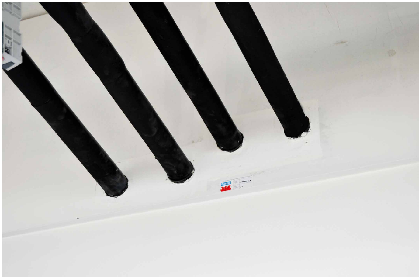
Prostupy potrubí s požárně ochranným pásem PROMASTOP®-W
