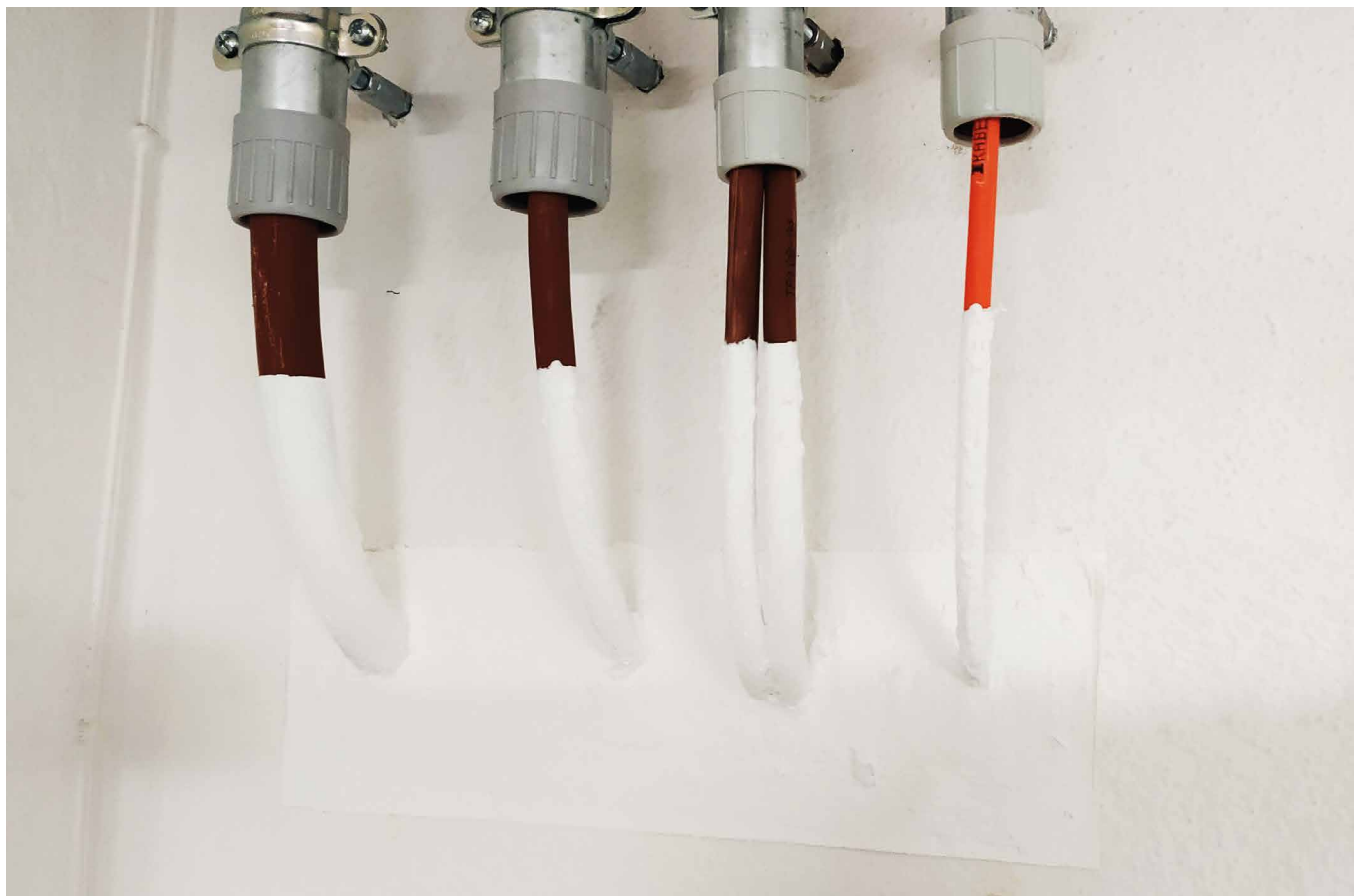
Kabelová měkká desková přepážka se stěrkou PROMASTOP®-I
