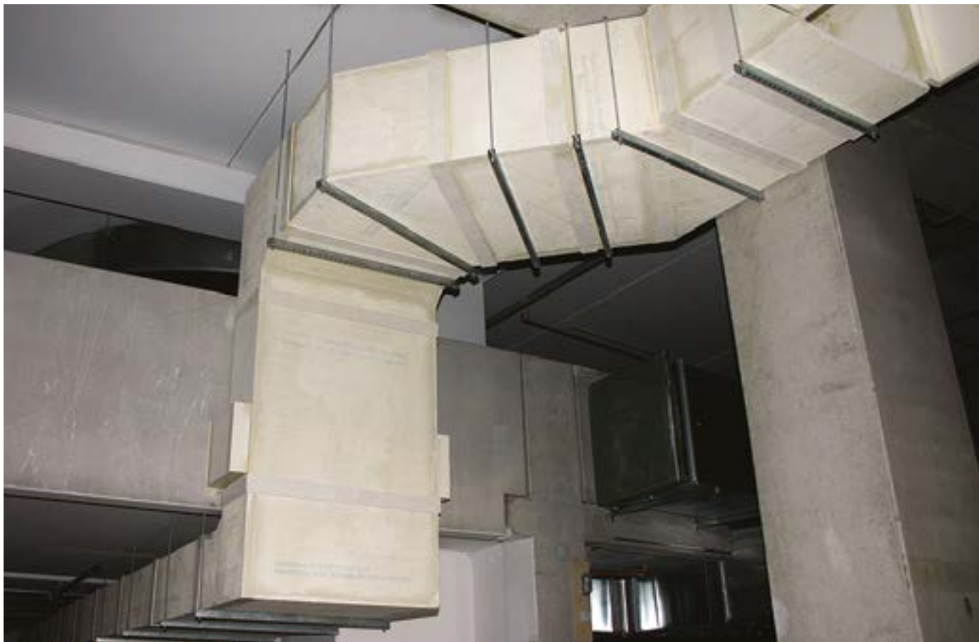
Ventilační potrubí z desek PROMATECT®
