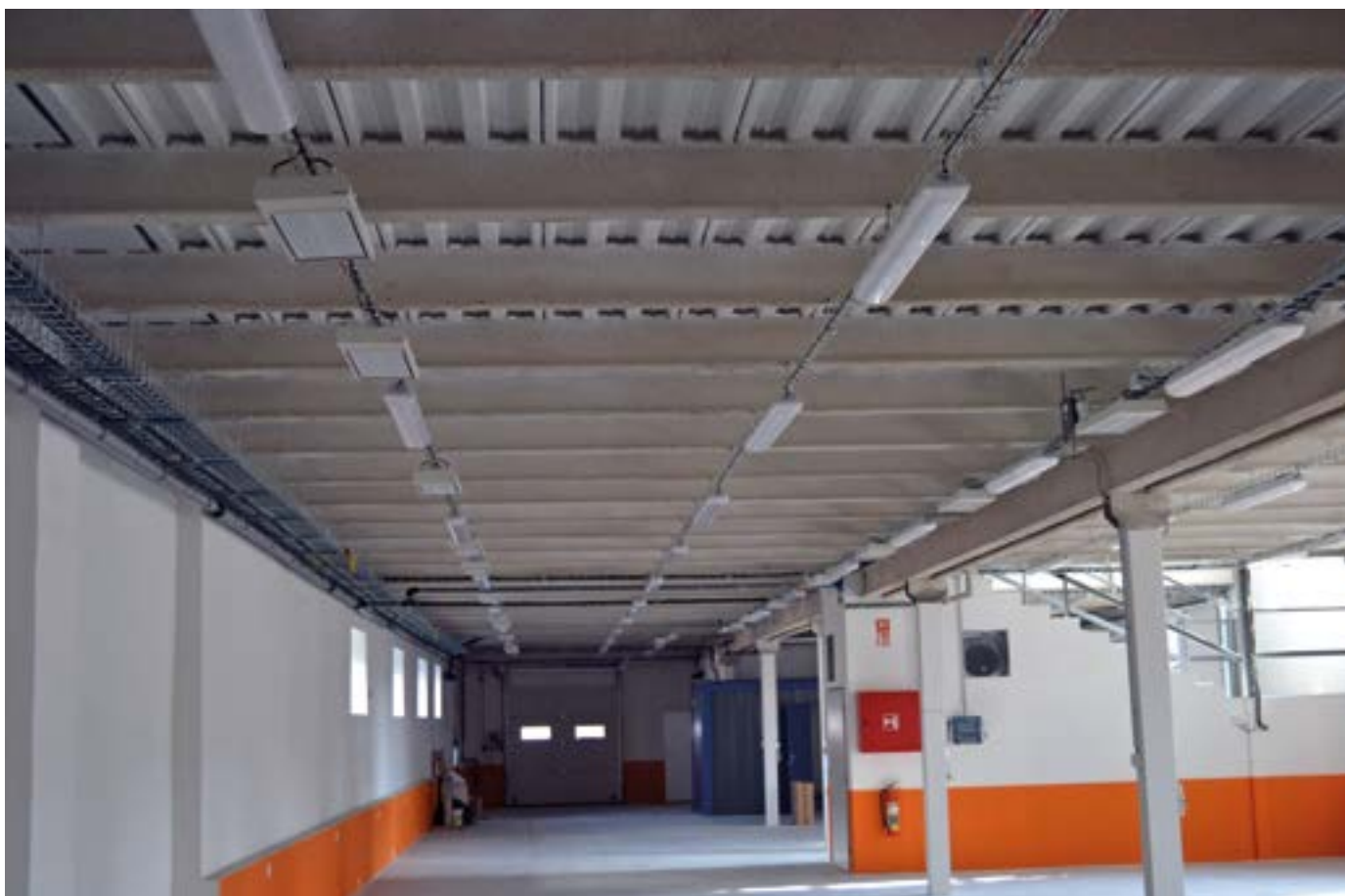
Strop z trapézového plechu
