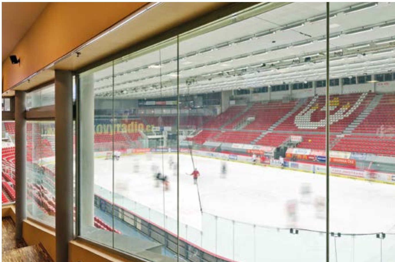
Prosklená stěna SYSTEMGLAS® na svislou silikonovou spáru
