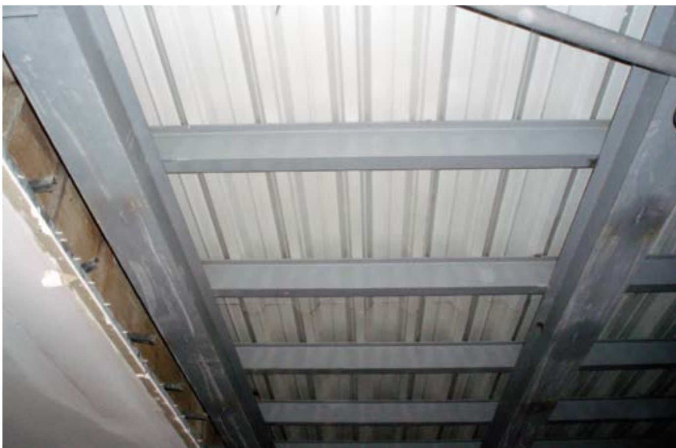
Strop z trapézového plechu
