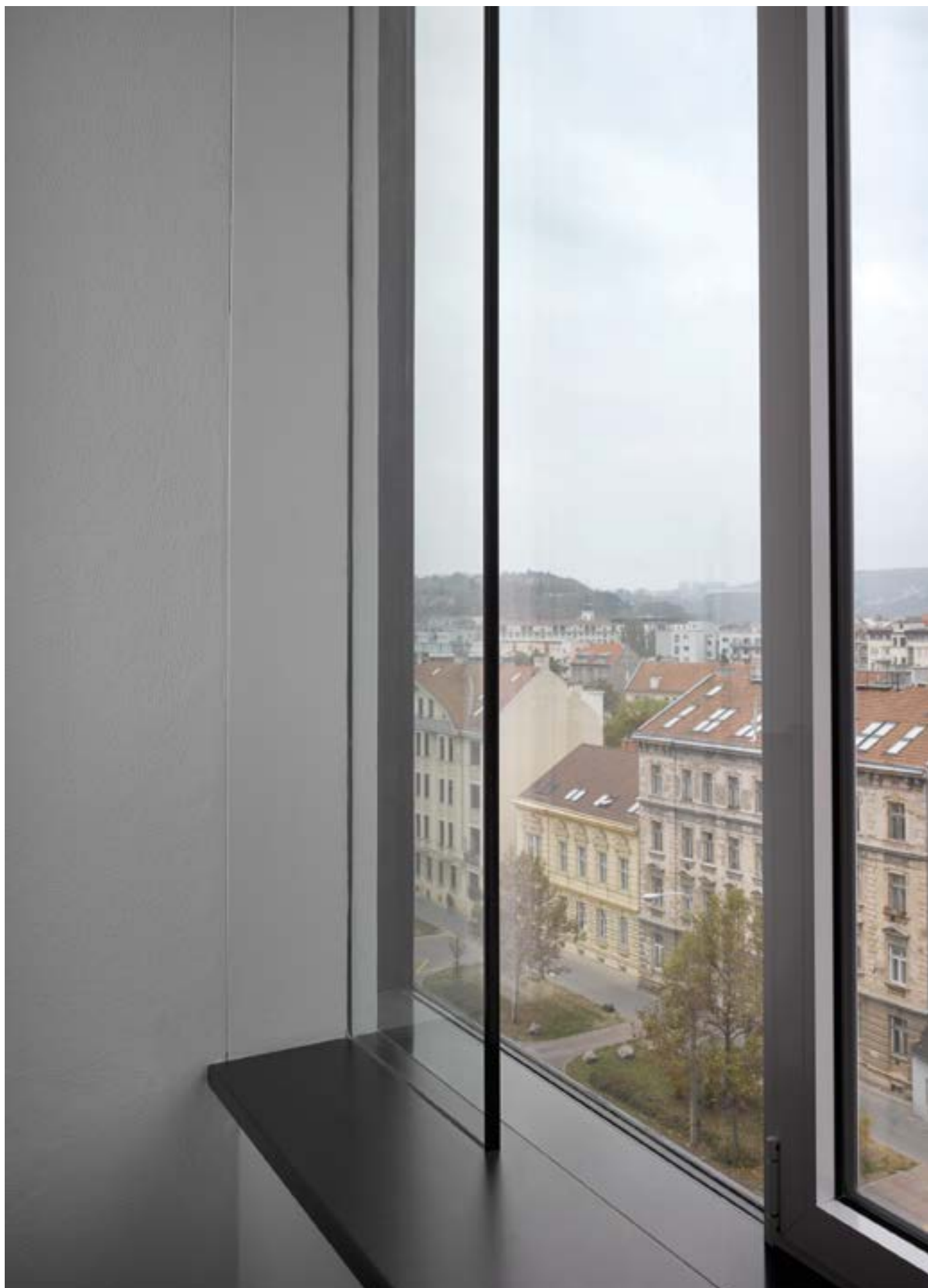
Svislý požární pás ze skel Promat®-SYSTEMGLAS
