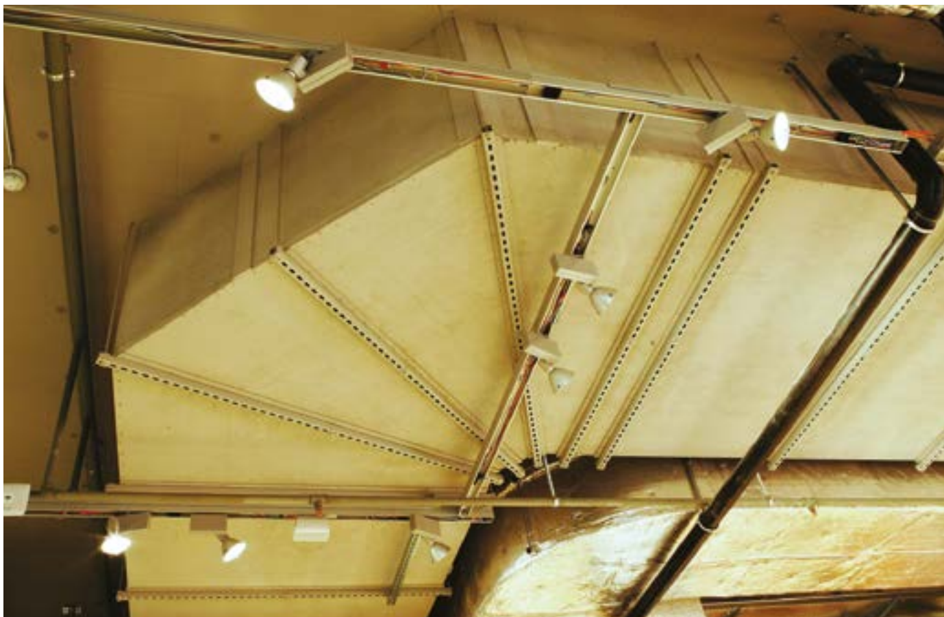
Ventilační potrubí z desek PROMATECT®
