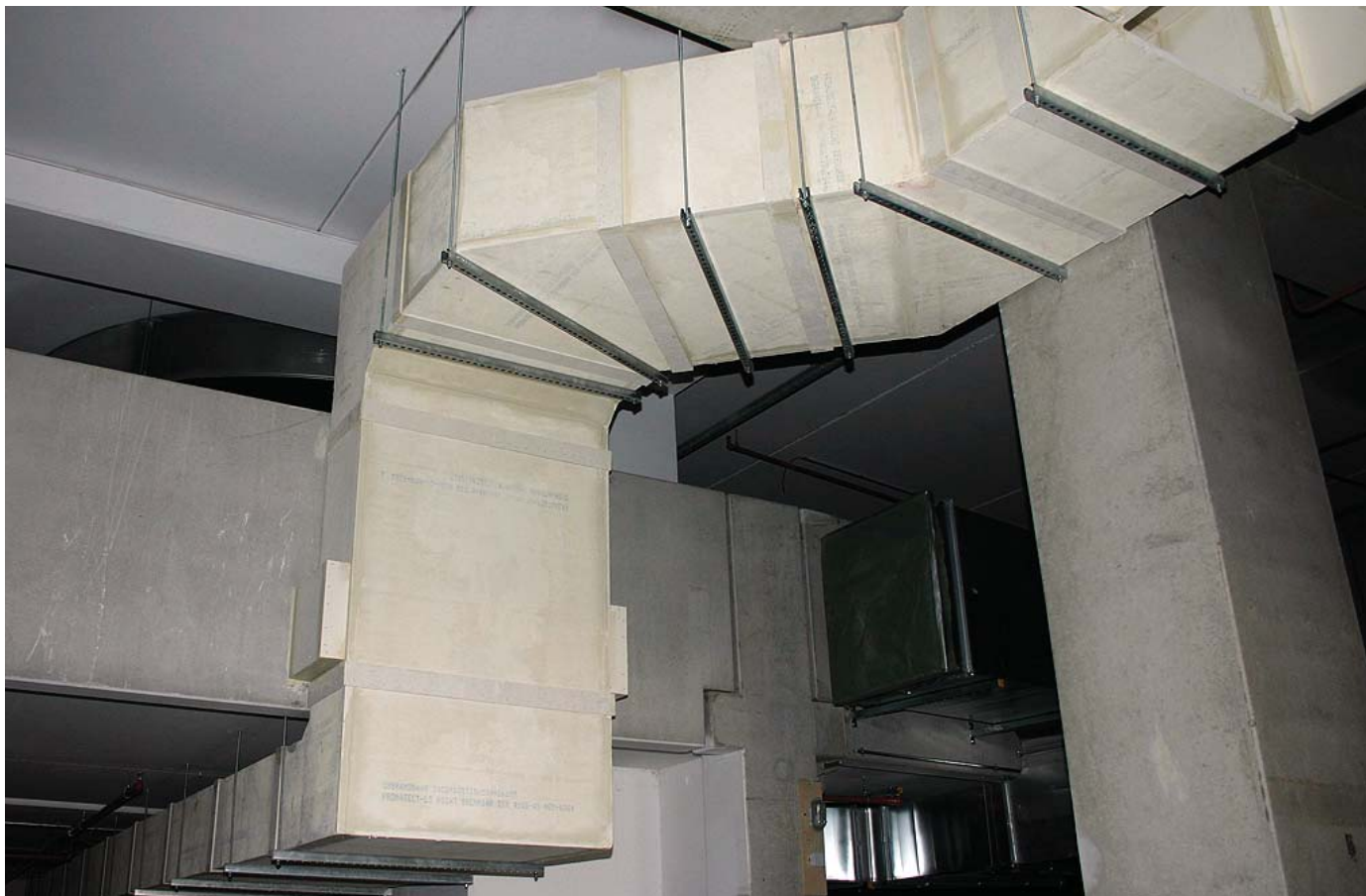
Ventilační potrubí z desek PROMATECT®
