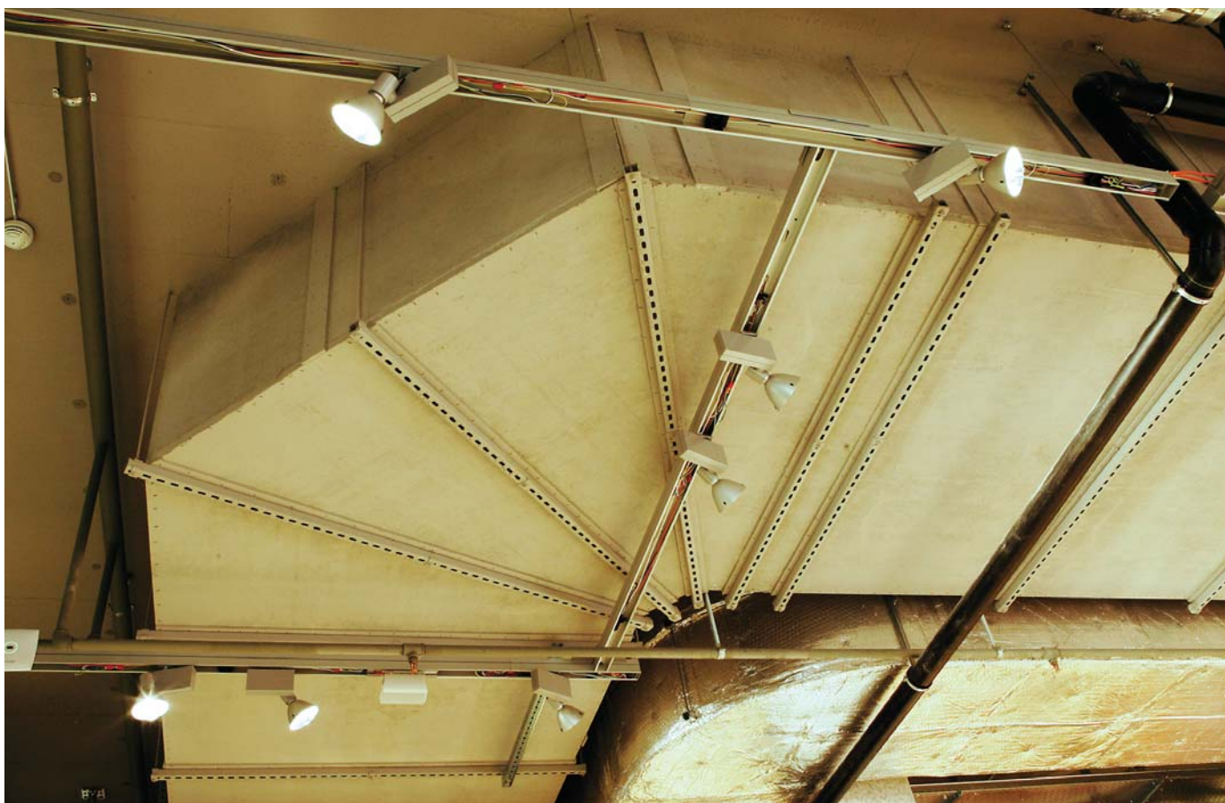
Ventilační potrubí z desek PROMATECT®
