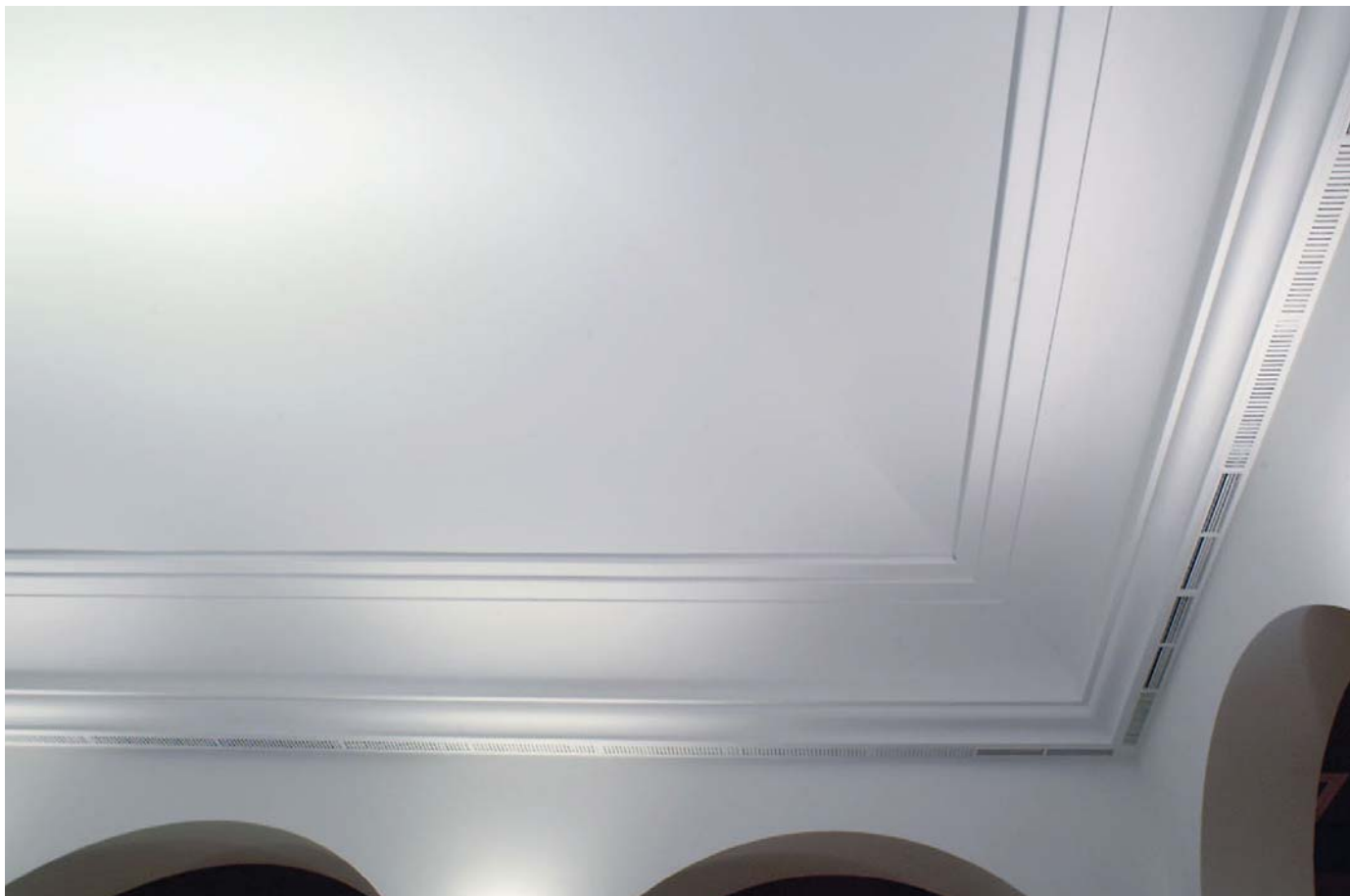
Podhled PROMATECT® pod dřevěným trámovým stropem
