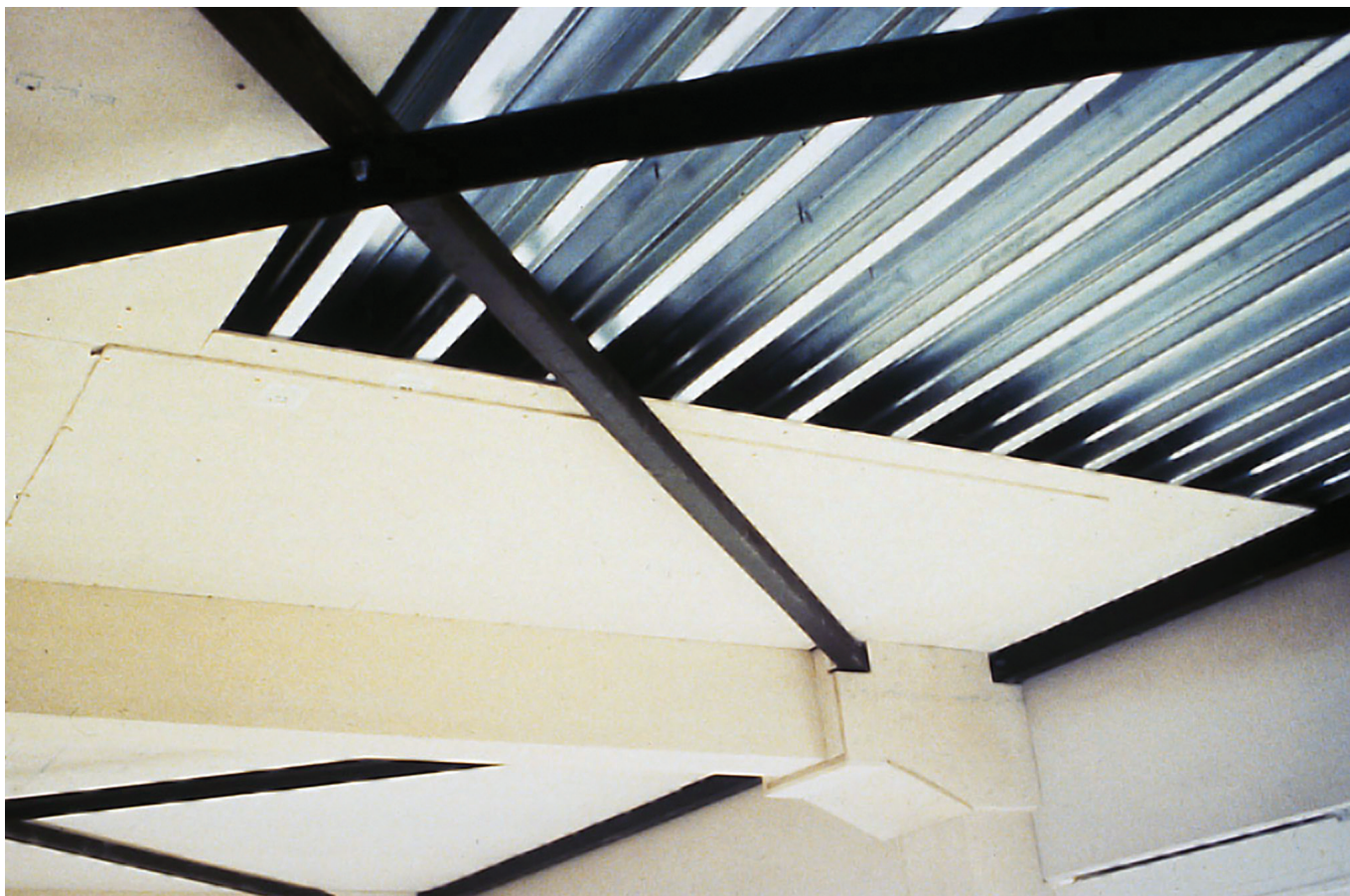
Podhled PROMATECT® pod stropem z trapézového plechu
