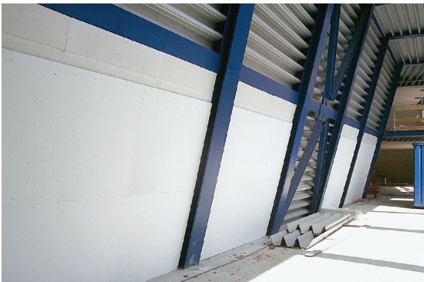
Podhled PROMATECT® pod střechou z trapézového plechu
