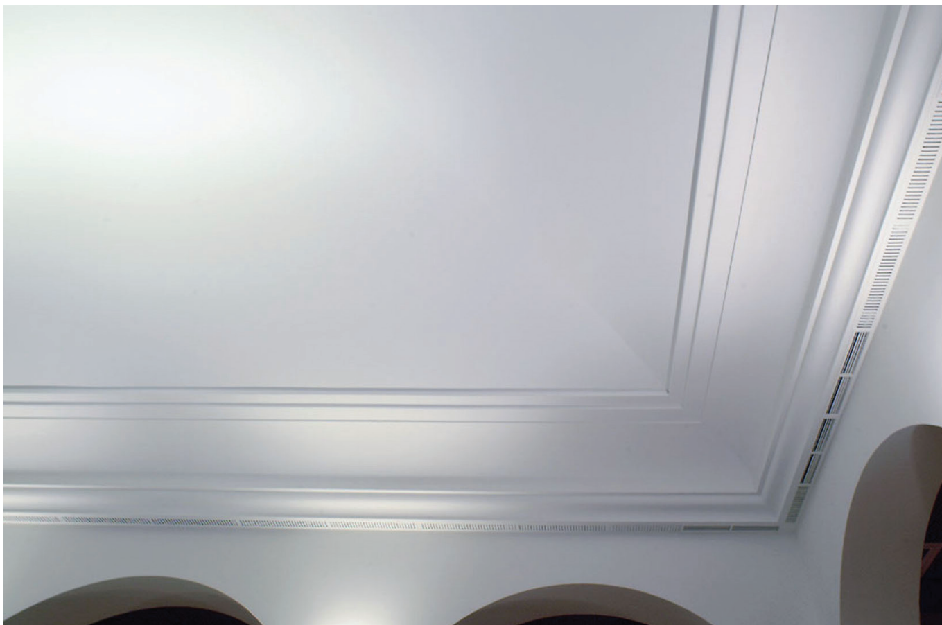
Podhled PROMATECT® pod dřevěným trámovým stropem
