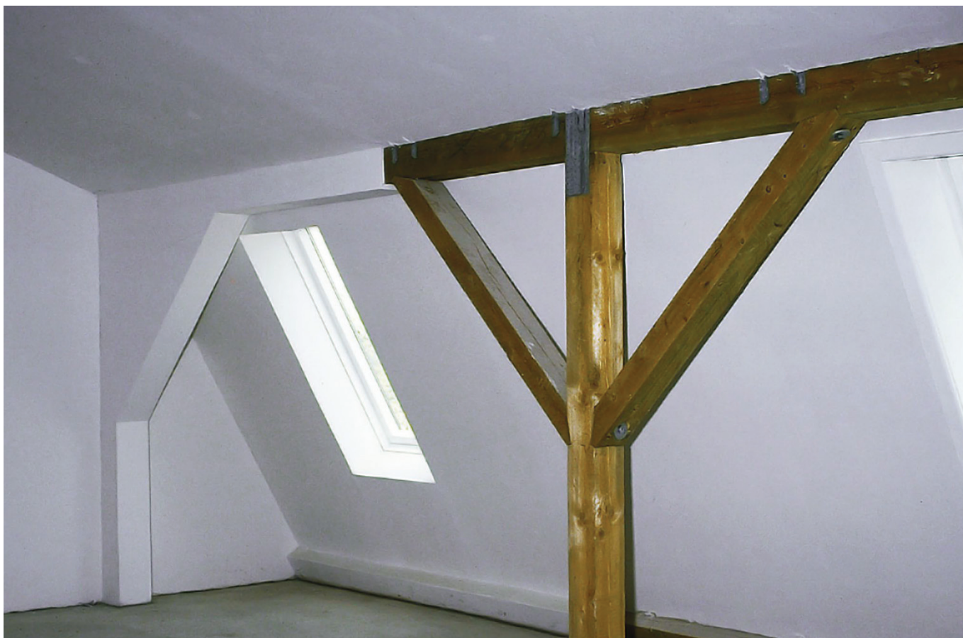
Podhled PROMATECT® pod střešní konstrukcí
