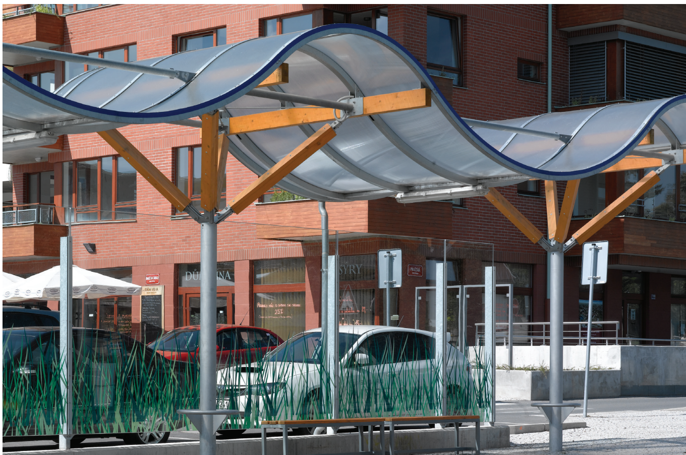
Skleněné výplně autobusové zastávky
