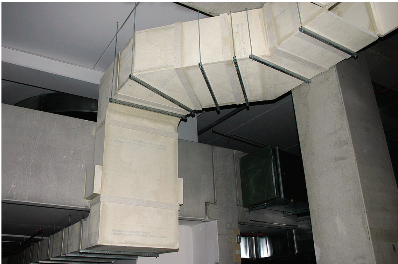
Ventilační potrubí z desek PROMATECT®
