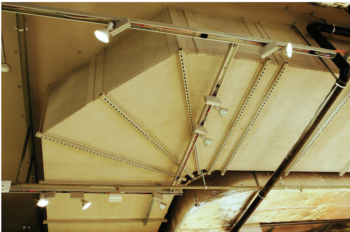
Ventilační potrubí z desek PROMATECT®
