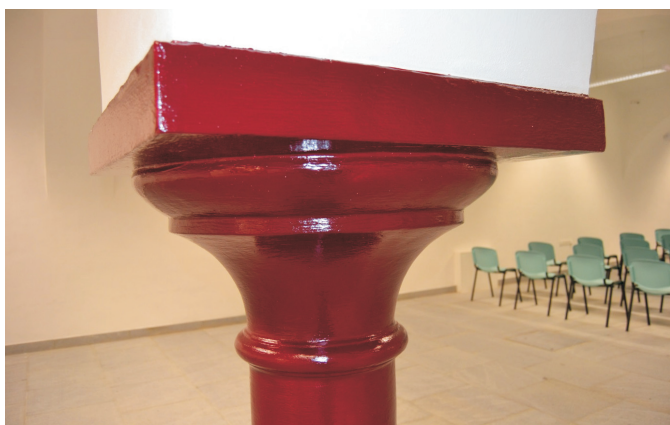
Foto 4 - Protipožární nátěr PROMAPAIN ® SC4
