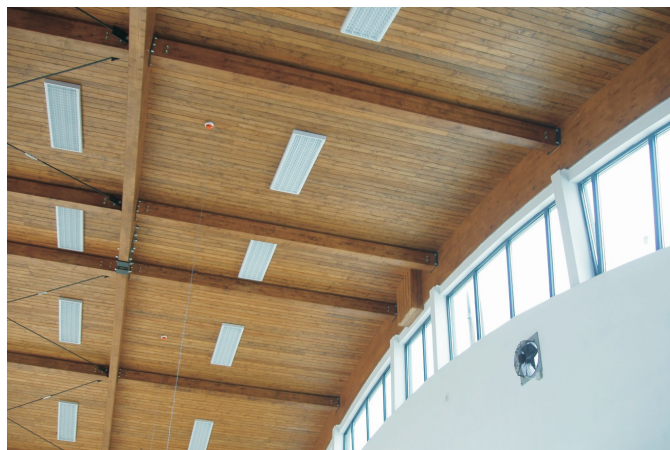
Foto 3 - Protipožární nátěr PROMADUR ® transparent
