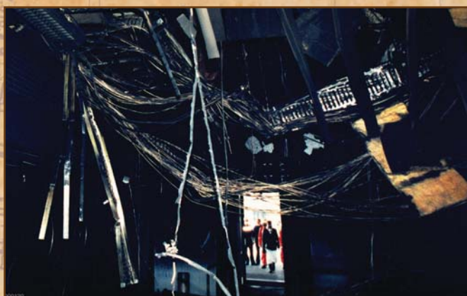
Požár elektroinstalací na letišti Düsseldorf
