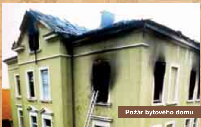
Rozsáhlý požár střechy
